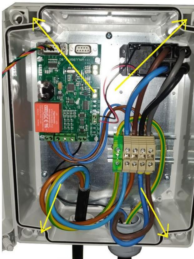
**Ne pas effectuer de nouveaux perçages pour ne pas impacter l'étanchéité du coffret.**
