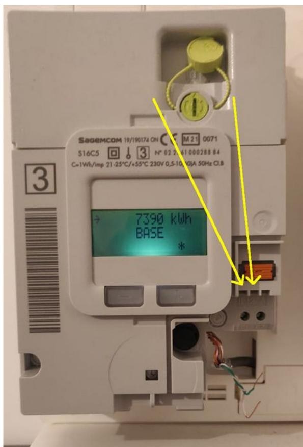
**Important:** Prendre garde à bien vous connecter sur les bornes I1 et I2 du compteur EDF, et surtout pas sur les bornes C1/C2 !
